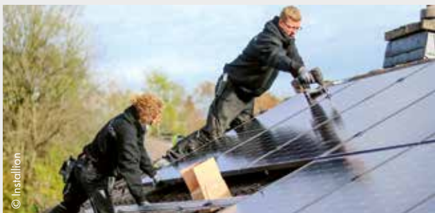
Montage einer Photovoltaikanlage
