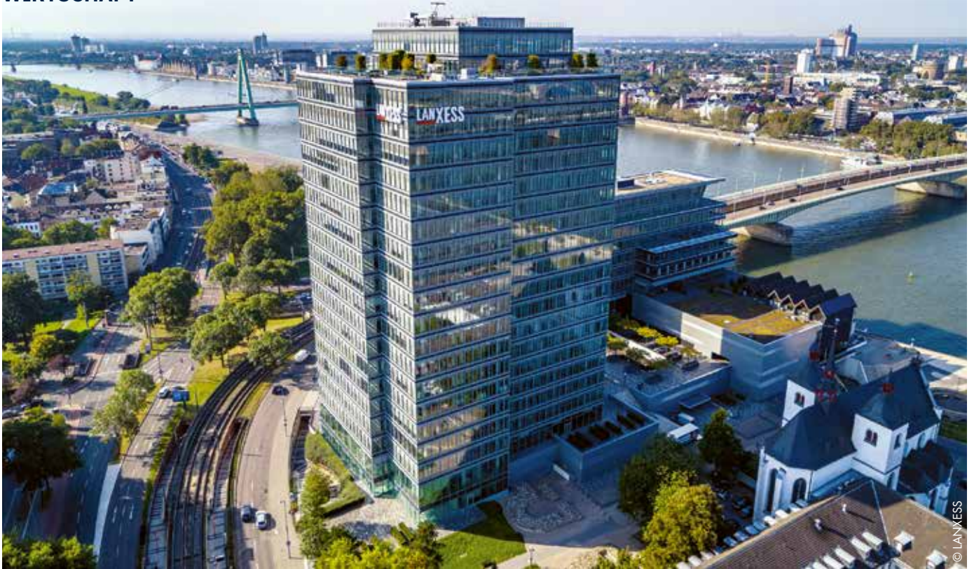
Der Spezialchemie-Konzern steuert seine weltweiten Geschäfte vom Kölner LANXESS Tower aus.
